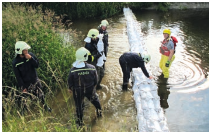
Deset sborů dobrovolných hasičů drahotoušského okrsku nacvičovalo stavbu protipovodňové hráze z pytlů plněných pískem. Foto: Veronika Hlavinková
