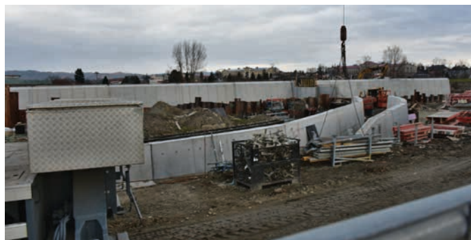
Rybí přechod u jezu se už rysuje. Bude dlouhý téměř 150 metrů. Foto: Petr Bakovský
