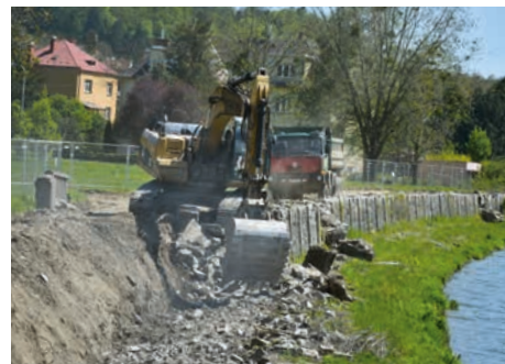
Povodí Moravy zahájilo stavbu nových protipovodňových hrází bouráním těch starých. Foto: Petr Bakovský
