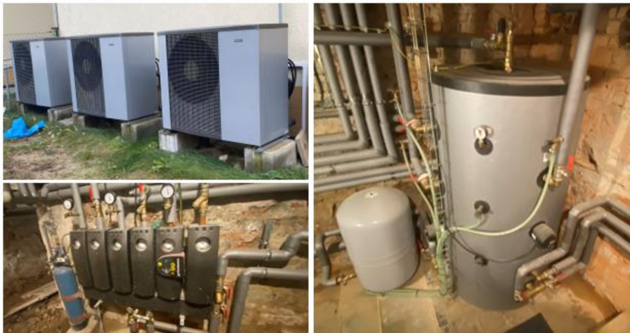
Obrázek 15 Tři tepelná čerpadla země-vzduch zásobující teplem budovu
