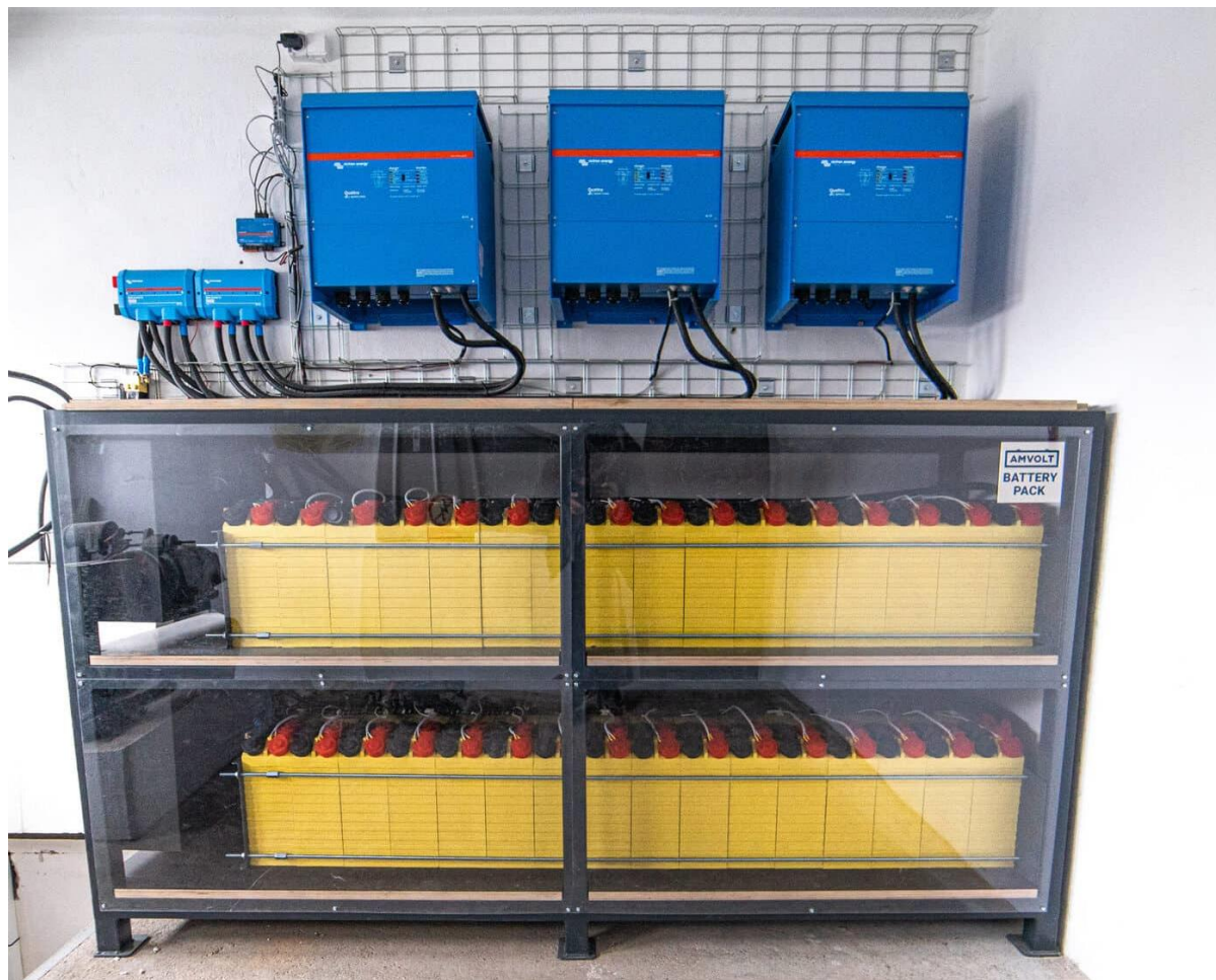
Obrázek 17 Sestava pro solární aplikace, střídače a bateriové úložiště 100 kW
