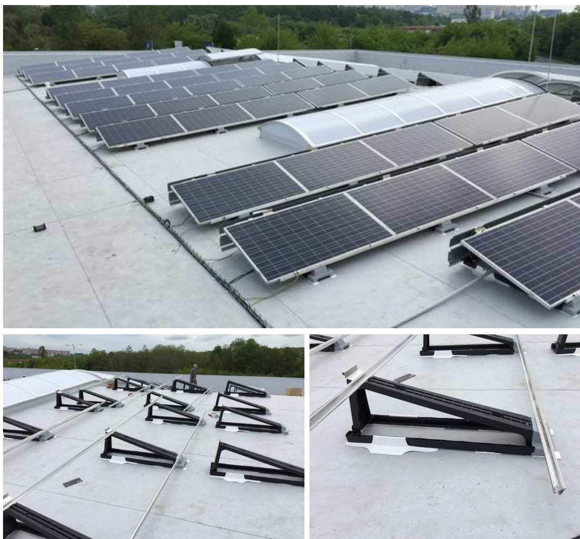
Obrázek 16 Instalace solárních panelů na ploché střeše
