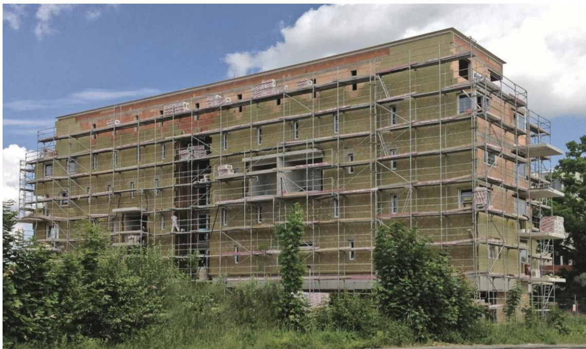
Obrázek 14 Ukázka zateplení fasády minerální vatou
